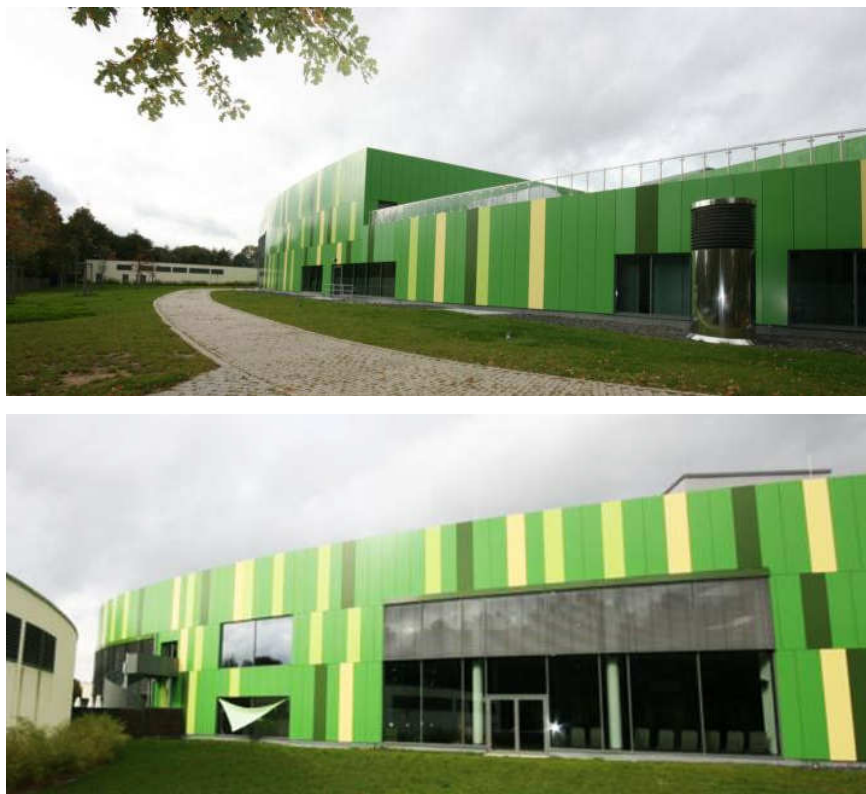
Abbildung 3: Außenansichten Bambados: Ost, Südost
