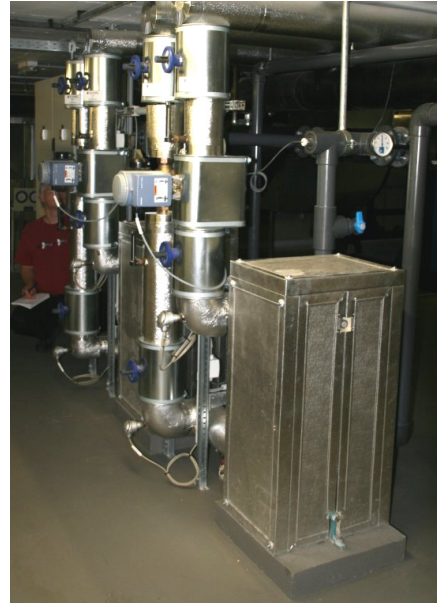
Abbildung 19: Links: Detail der Wärmeversorgung mit NT- („BHKW Abluft“) und HT-Netz aus der Ausführungsplanung zum Beckenwasserkreislauf von Becken 3 (Quelle: Eneratio). Rechts: Foto von einem Wärmeübertrager des Beckenwasserkreislaufs.
